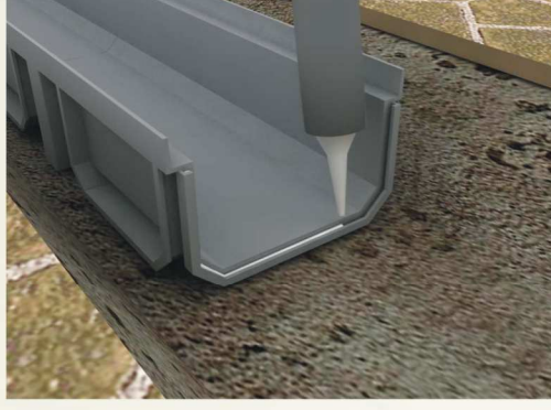
Bağlantı yapmak için PU mastik uygulayın
